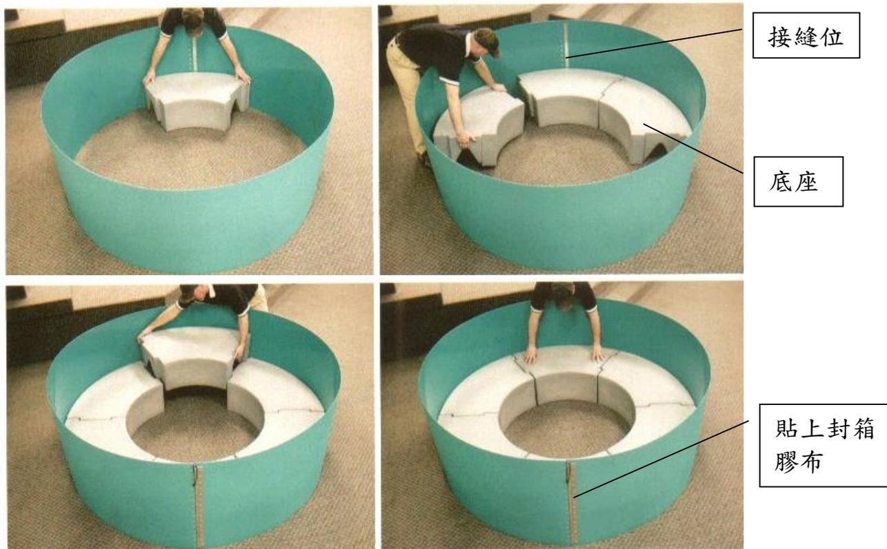
6. 於綠色圍邊外圍的接縫位置貼上封箱膠布，避免安裝浸池膠袋時刮損膠袋。
